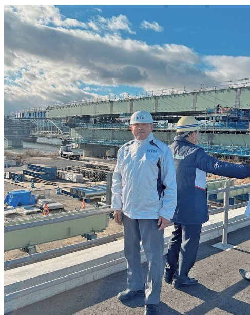
伊勢大橋架け替え工事視察の状況②
