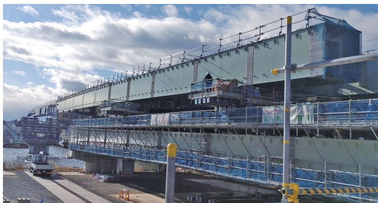
伊勢大橋架け替え工事視察の状況①
