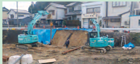
護岸工事開始し現在は完成済み
