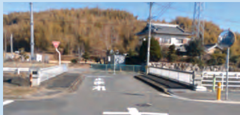
橋の歩道部分の片側撤去および道路拡幅
