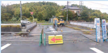
橋の歩道部分の片側撤去および道路拡幅
