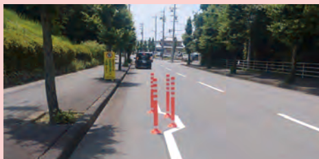
ポールで道路幅を一部縮小①
