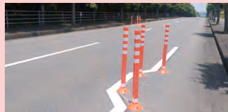
ポールで道路幅を一部縮小②
