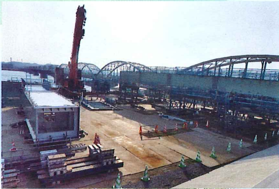
伊勢大橋架け替え工事風景
