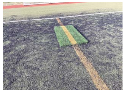
部分補修の為人工芝に凹凸ができています
