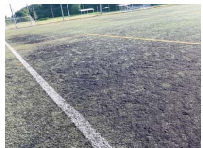
芝が擦り切れて充填材が流れだすグラウンド
