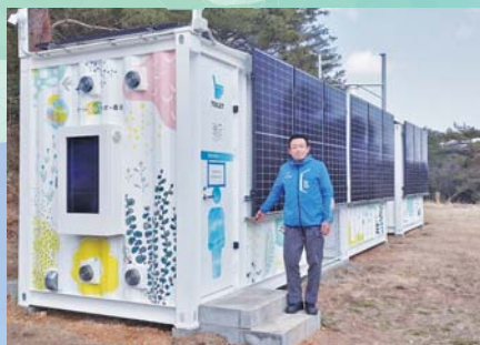
NTN多度山上公園に設置されたN³循環式トイレ
