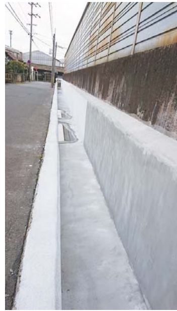
修繕完了写真
