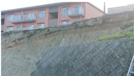
←今回視察をした護岸工事写真です。作業中でも護岸砂がさらさらで崩れ落ちてきたとのことでした。
