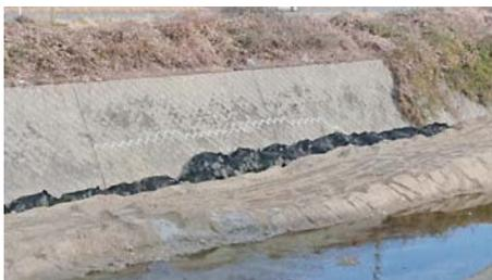
←視察中工業者が亀裂を発見した護岸です。亀裂した部分の護岸ですがよく見ると下がっているのが分かります。川の流れも護岸に当たらないように工事しました。以上
