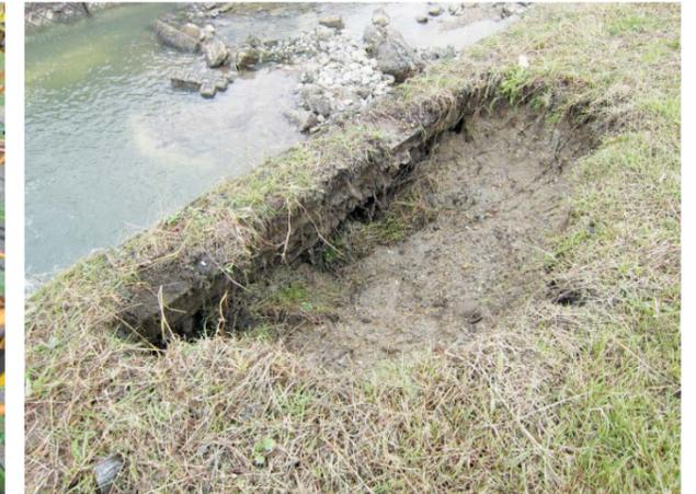
県管理の大山田川です。左写真：2017年7月10日の集中豪雨陥没。右写真：台風21号時の陥没です。
