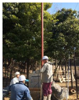
深井戸式メインポンプ設置
