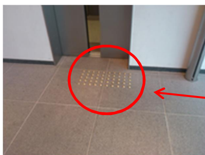
誘導ブロック
