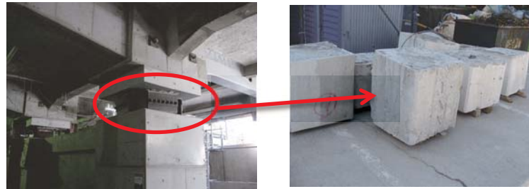
柱をカットし、天然ゴム系積層ゴムをいれていました。
