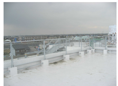
写真は現場に行きました完成した伊曾島小学校屋上フェンスです。
