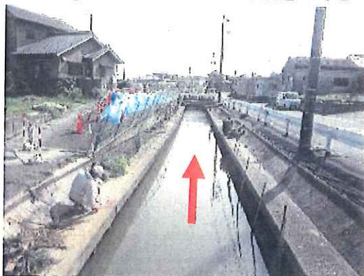
① No.0+44付近から下流をのぞむ
