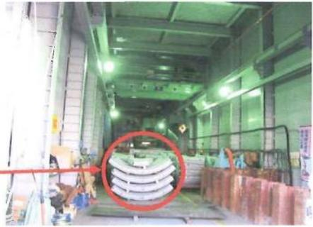
レールもポイントもありトロッコ列車のようでした。上の新聞のように300m半径で曲がっている現場です。右写真のように、1ブロックの管路は5枚で構成されています。
