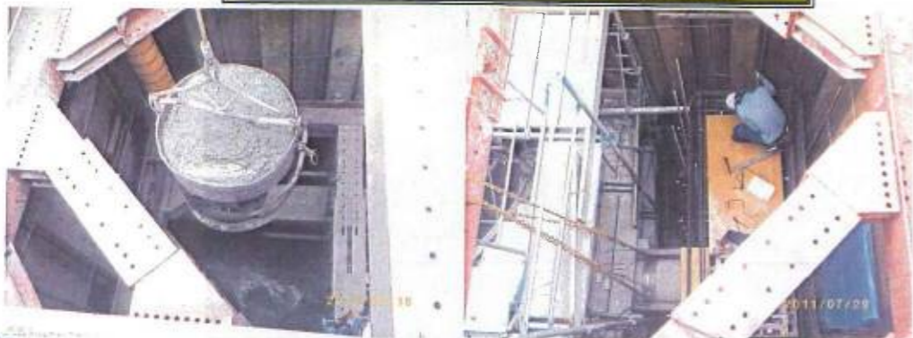
コンクリート打設
