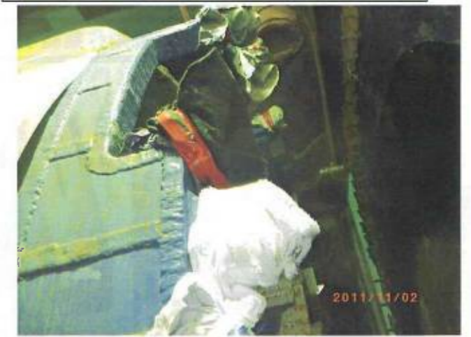
入口のゴムパッキンを傷めないように養生した
