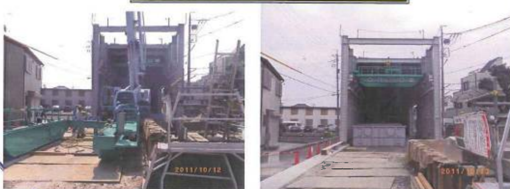
※緑色の天井クレーンを防音ハウスの柱に取付け、トンネル工事に使用します。
