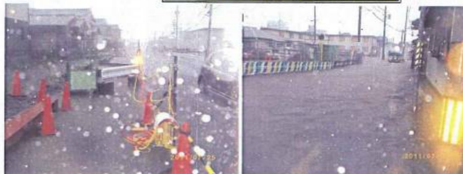
7月25日、17:00頃の集中豪雨(90mm/h)で水路があふれて、川のように became. 水の中で一般車の誘導をしながら、当工事の使命を体で感じました。
