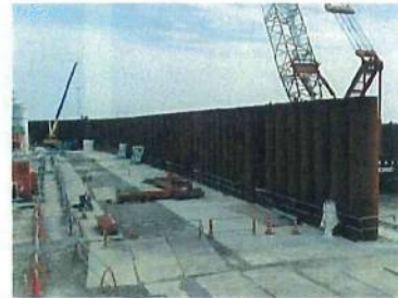
鋼管矢板の打ち込み後
