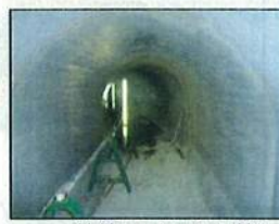
接続トンネル(3号機)
