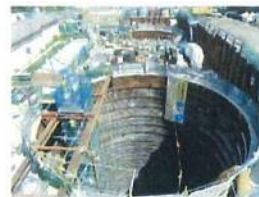
1・2号機放水路部 掘削工事
