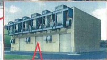
緊急時ガスタービン発電機建屋 <免震構造>
