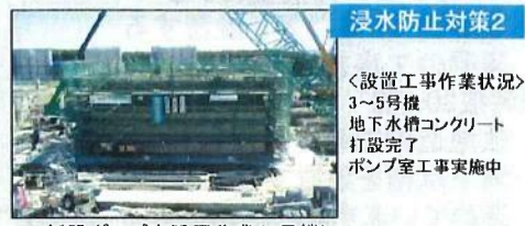
新設ポンプ室設置作業(3号機)
