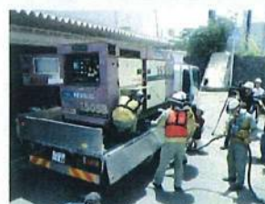
通信設備への電源供給訓練 (発電機設置の様子)
