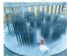
5号機放水路部 深礎基礎部完了
