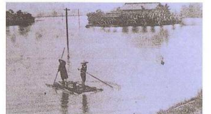
水の中に孤立した家屋(岐阜県羽島市)(昭和36年6月) 岐阜新聞提供
