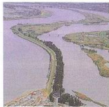
千本松原(油島締め切り工事の名残) ～木曾三川公園から下流を見る～
