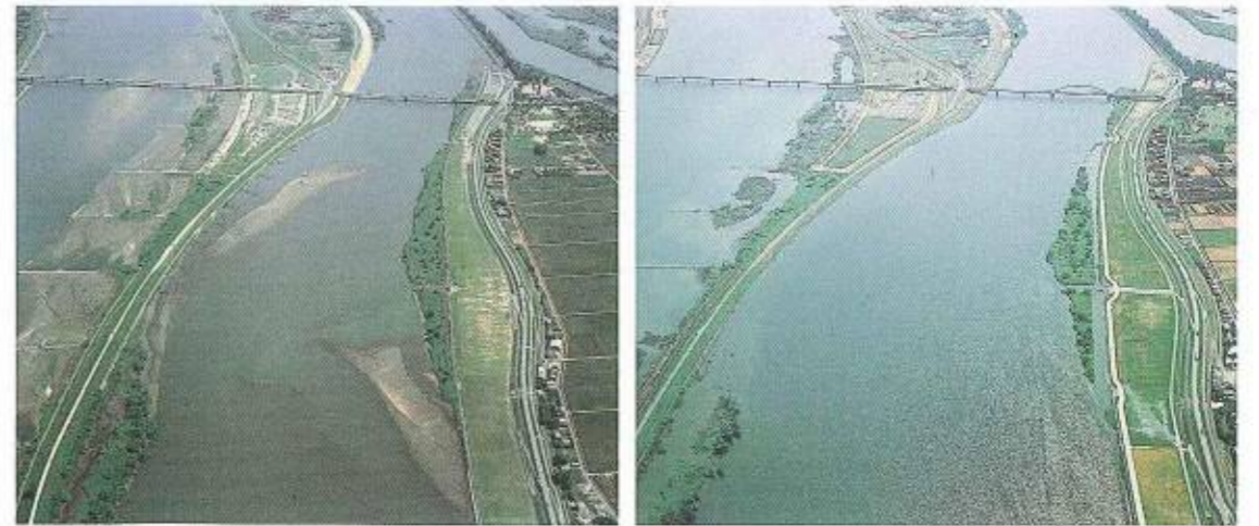
しゅんせつ前のマウンド区間
