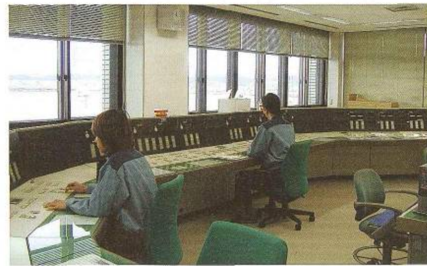
◀管理所操作室 長良川河口堰の管理は、左岸にある管理所で行っています。操作は、堰上下流水位、流入量等のデータにより自動制御で行っていますが、操作室では操作員が24時間体制で、監視、操作にあっています。
