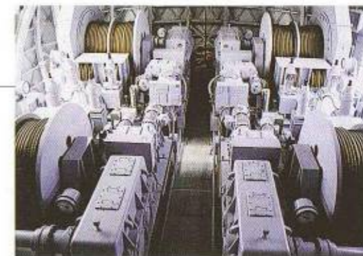
ゲートの開閉装置
