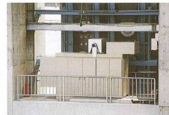
機側予備発電装置(1号堰柱)
