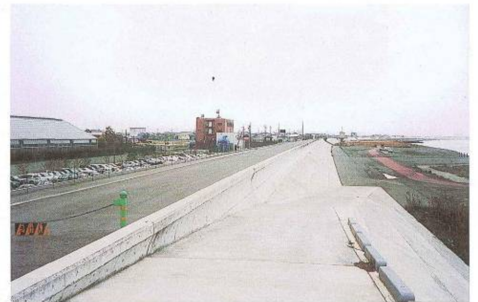
波返し等により補強された高潮堤防(桑名市長島町)
