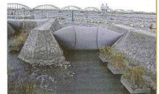
ゴム引布製起伏堰（せせらぎ魚道上流部）
