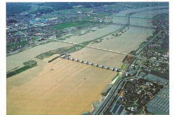
平成16年10月出水時の長良川河口堰地点の状況
