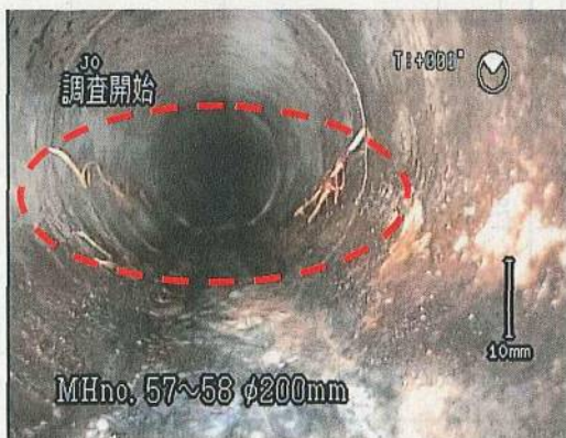
写真1 クラック(ひび割れ部分)から生え出した木根
