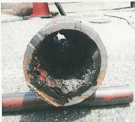
写真1 約70年使用された配水管の切断面 ※管内壁の付着物は、水に含まれる鉱物等
