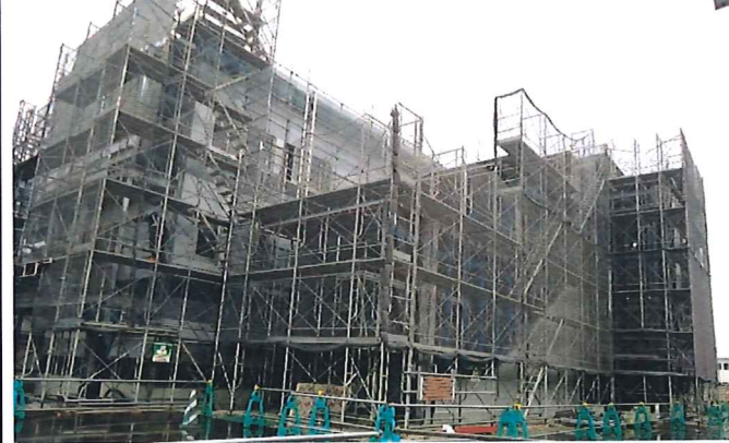
②西側昇降部
