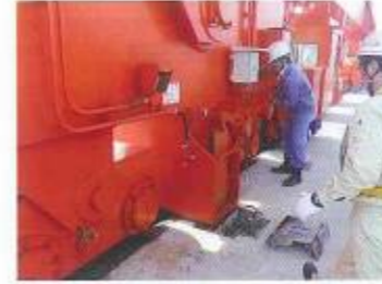
コンテナ・荷役機械固定
