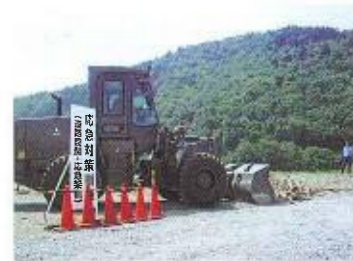
応急対策（道路啓開）
