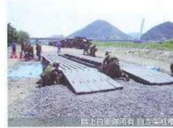
応急対策（応急架橋）
