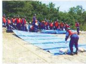
水防工法（シート張り工）
