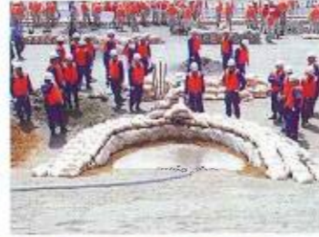
水防工法（月の輪工）
