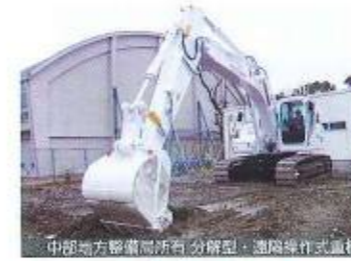
分解型・遠隔操作式重機の操作
