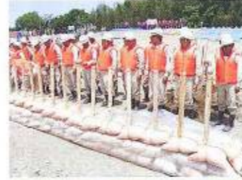
水防工法（積み土のう工）
