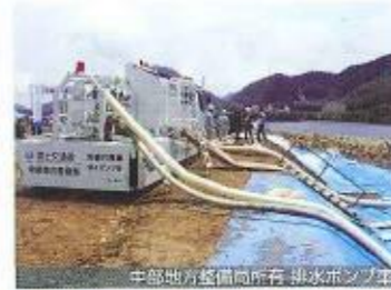
排水ポンプ車操作
