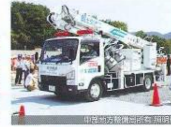
照明車設置作業
