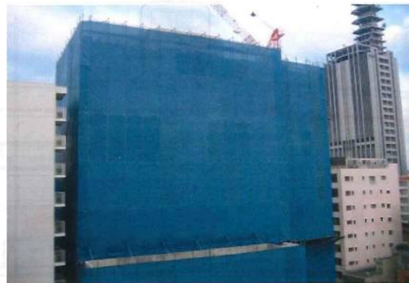
メッシュシート施工例
