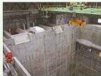
3 ごみピット・ごみクレーン
