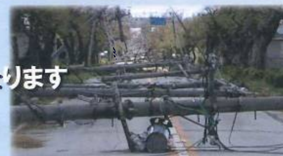
写真：2003年台風14号の強風被害（宮古島地方気象台）
