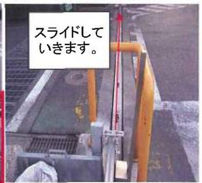
場内での雨水が当日このように熱処理に入って来ましたが、稼動式の防水盤でブロックし地下ピット浸水は免れました。
