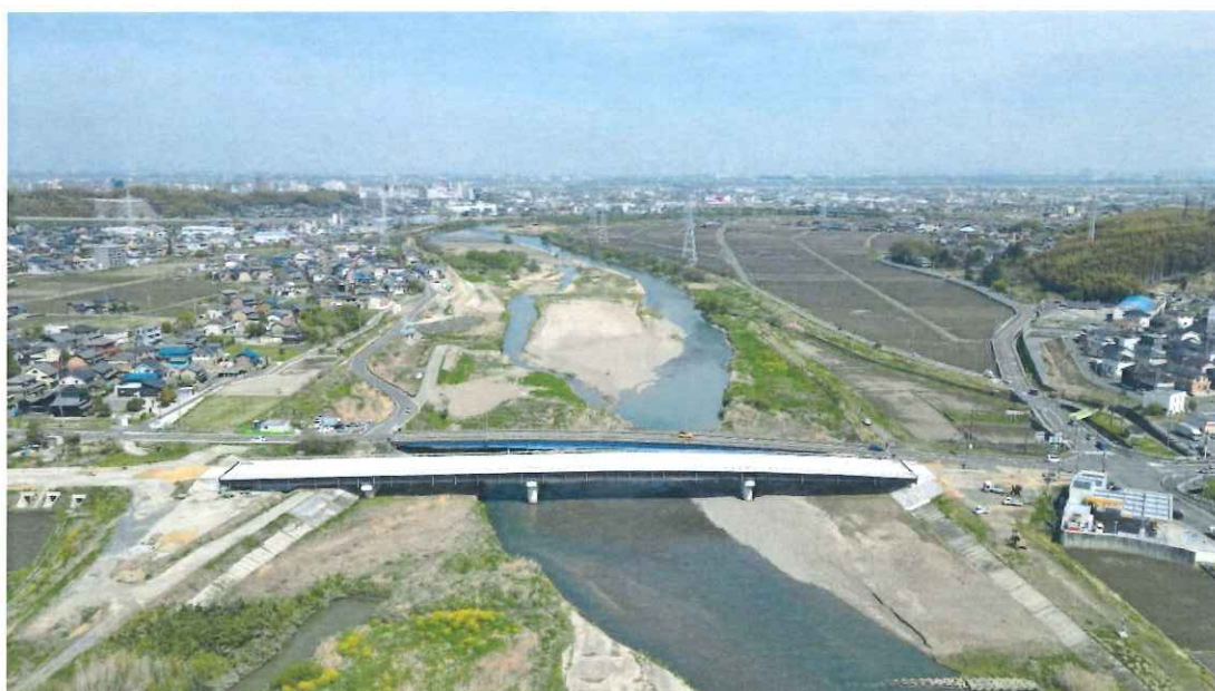
（員弁川河川改修事業 桑部橋上部工：上流から下流方面を望む）
