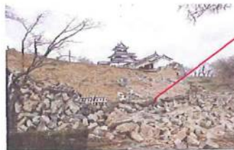
①本丸南面崩落状況
