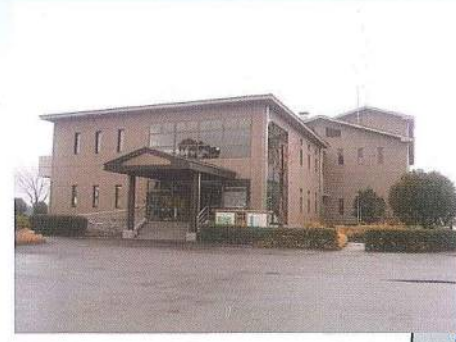
ながしまじょうか 長島浄化センター (汚水処理施設)
