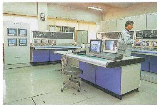
しゅうちゆうかん しつ 集中監視室
