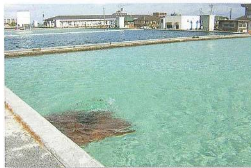
かんそく かし 緩速ろ過池
