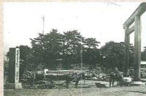
昭和初期の七里の渡し跡 (昭和9年 伊勢大橋竣工記念の絵はがき集より)
